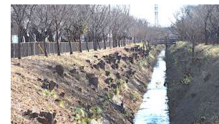
2021.1 皆伐状態の玉川上水
